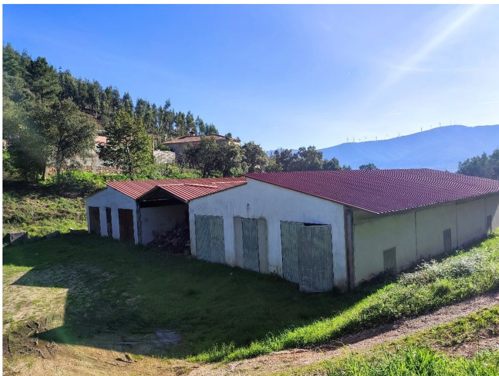
Foto 4: Vista geral do edifício (sentido poente / nascente)
