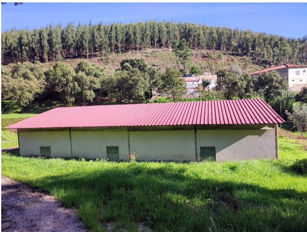
Foto 3: Vista geral do edifício (alçado poente)
