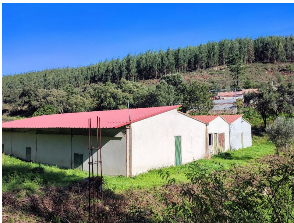
Foto 2: Vista geral do edifício (sentido sul / norte)
